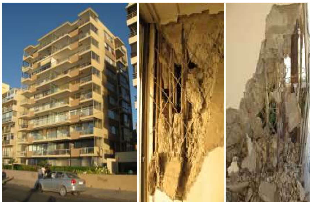
Daños en edificio Bahía sector Avenida Perú en el año 2010, demolido el año 2012
