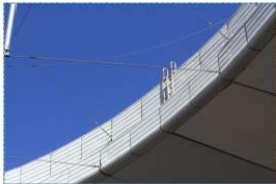
FOTO 1 (Foto desde lateral de campo de la halla)
